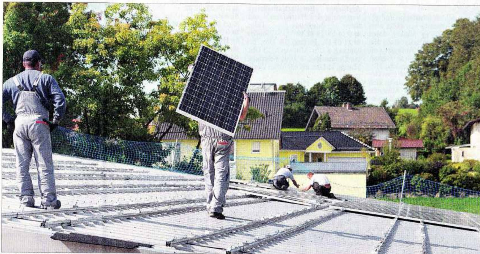
Modul für Modul schleppen die Monteure der Solea AG aufs Parkdeck-Dach. Im Lauf der kommenden Woche wird die Anlage erstmals Strom ins Netz einspeisen.
